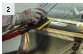
2 Spachtel ebnen und Übergänge schleifen OSP-3, OSP-4
