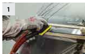
1 Lack entfernen und Übergänge schleifen OSP-2, OSP-3
