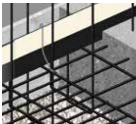
Befestigung an der Bewehrung mit Haltebügeln
